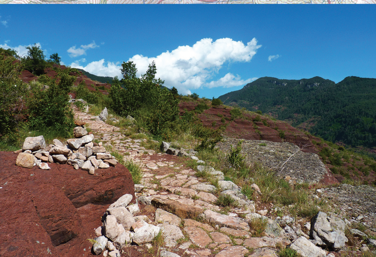
Des blocs de quartzite ont été utilisés pour le pavement du chemin (sentier du Point Sublime). © Héloïse Granier
